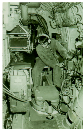
2 - mise en service de la caméra Photothèque Amhydro - J-Y Devilliers
