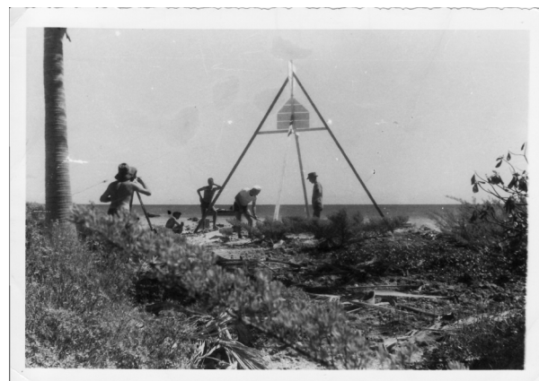
7 - construction d'une pyramide photothèque Amhydro - N. Cloatre
