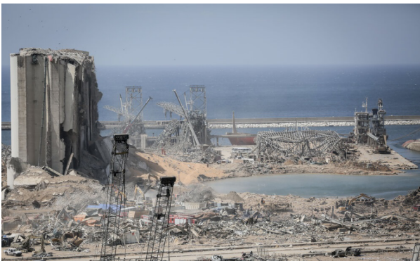
2 - vue du lieu de l'explosion
