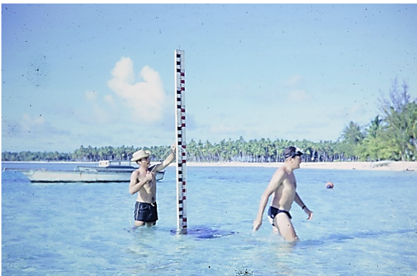
5 - mise en place de l'échelle de marée photothèque Amhydro - M. Marchand
