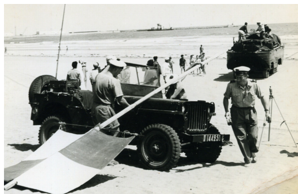
2 - préparation des travaux sur la plage photothèque Amhydro - X
