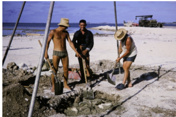
4 - bétonnage d'une borne sous une pyramide photothèque Amhydro - M. Marchand
