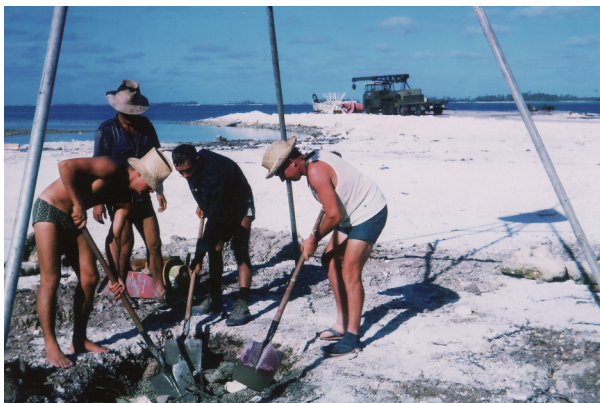
3 - renforcement d'une borne géodésique en prévision du 1er tir en août 1966 à « Dindon ». Pour faire partie de l'équipe il fallait savoir faire du béton et ne pas avoir peur de « crocher dedans » sans distinction de grade ! photothèque Amhydro - N. Cloatre
