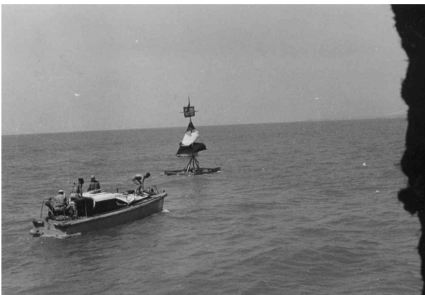
1 - les balises hydrographiques permettent de travailler au large photothèque Amhydro - M. Berger
