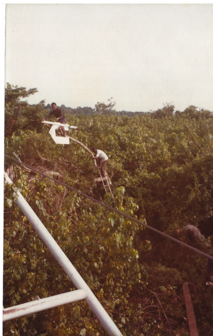
4 - pose de signaux en bois dans les arbres photothèque Amhydro - P. Nicolas
