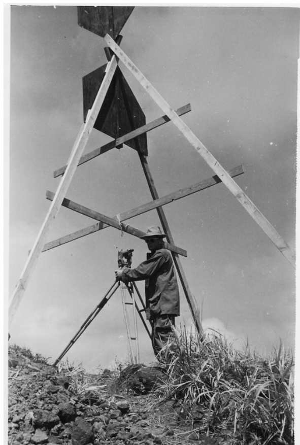
5 - signal installé par les hydrographes - Gambiers 1967 - photothèque Amhydro - N. Cloatre
